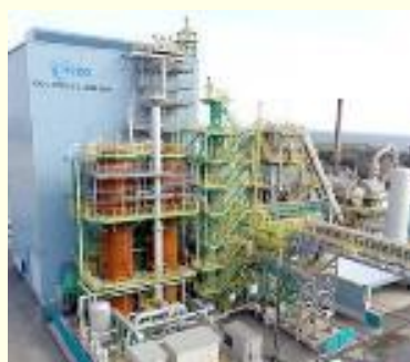
水素還元等プロセス試験高炉
